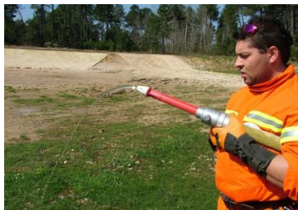
Immagine 53 - esempio problematiche dovute alle eccessive perdite di carico e all'utilizzo di non idonee pompe.
