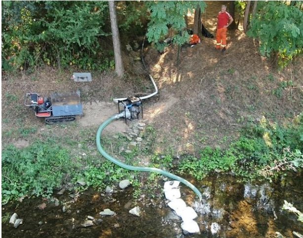
Immagine 58 - installazione di una motopompa su fiume per la captazione dell'acqua utilizzata per il rifornimento idrico di una vasca AIB – incendio Camaiore 2021_08_14.
